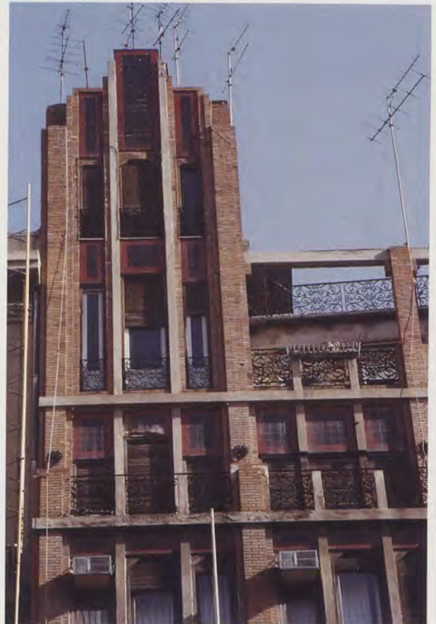
RIETA, Joaquín: Edificio Cervera . Plaza del Ayuntamiento, 10. Valencia.
