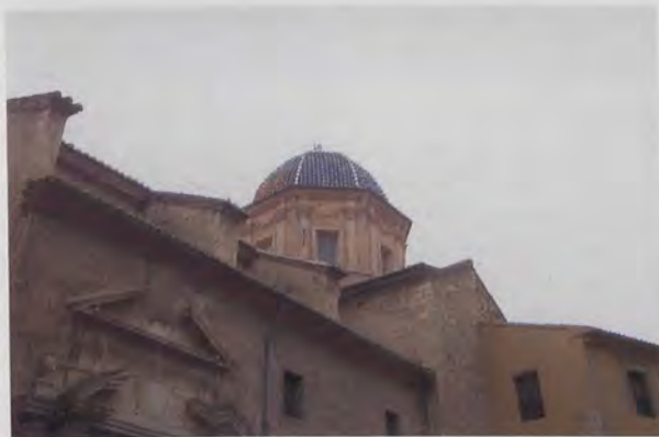
Fig. 5.- Exterior de la cúpula de la iglesia del Colegio de Segorbe.
