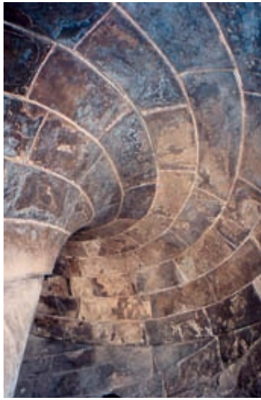
Fig. 2.-Escalera con bóveda de cañón helicoidal en la puerta de las Victorias del El Cairo, Egipto.
