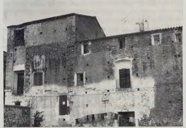
3.—Palacio de los Vivas, en Benifairó. Pared interior del patio.
