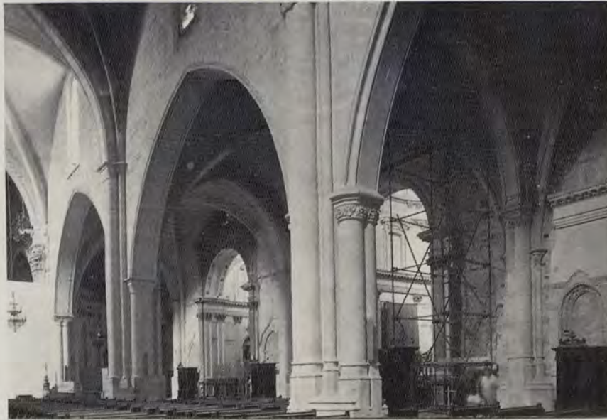
Otra vista de las obras de ripristinación.
