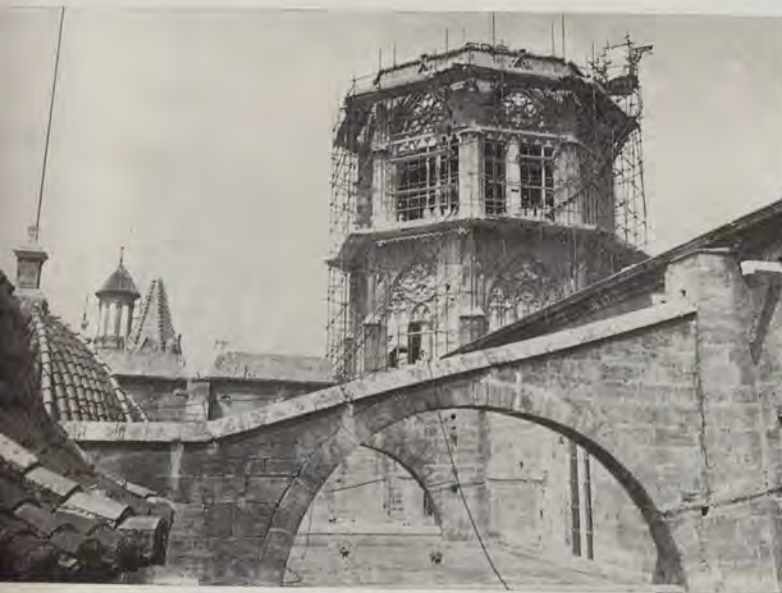
El cimborio, en proceso de consolidación y restauración.
