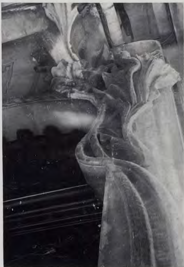
Detalle de la casa número 17 de la calle de San Nicolás de Alcoy, obra del arquitecto V. Pascual.
