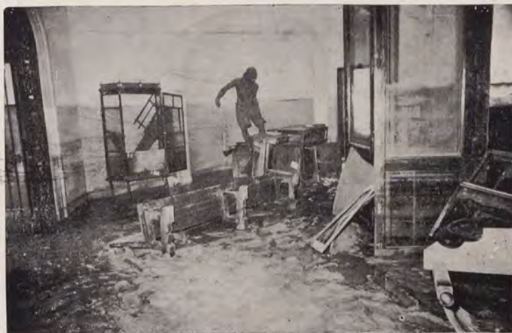
El zaguan del edificio de San Pio V, después de la riada
