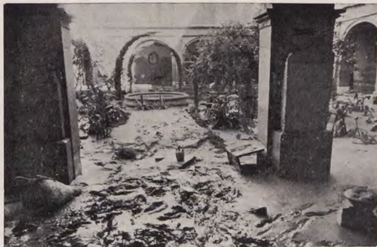
Aspecto del patio de San Pío V, al retirarse las aguas
