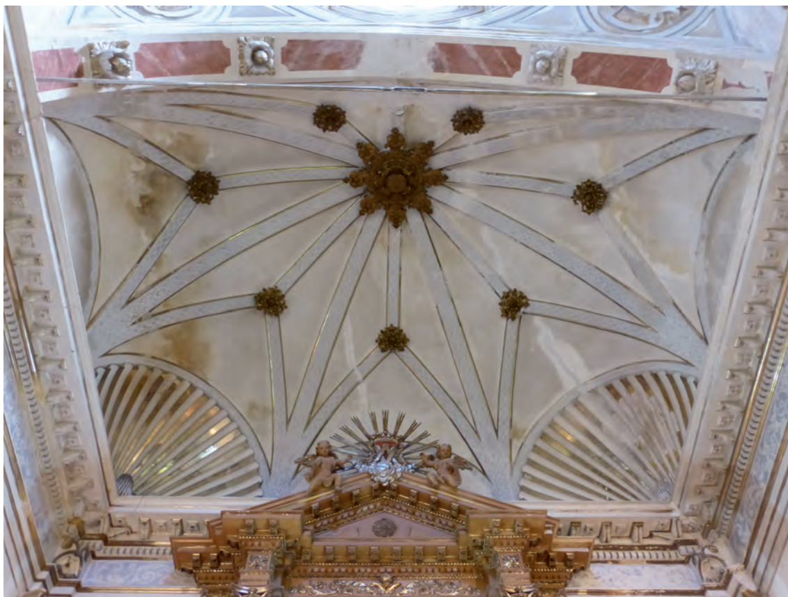
Fig. 5.- Bóveda del presbiterio en la Capilla de la Comunión del Convento del Carmen, Valencia (1613)
