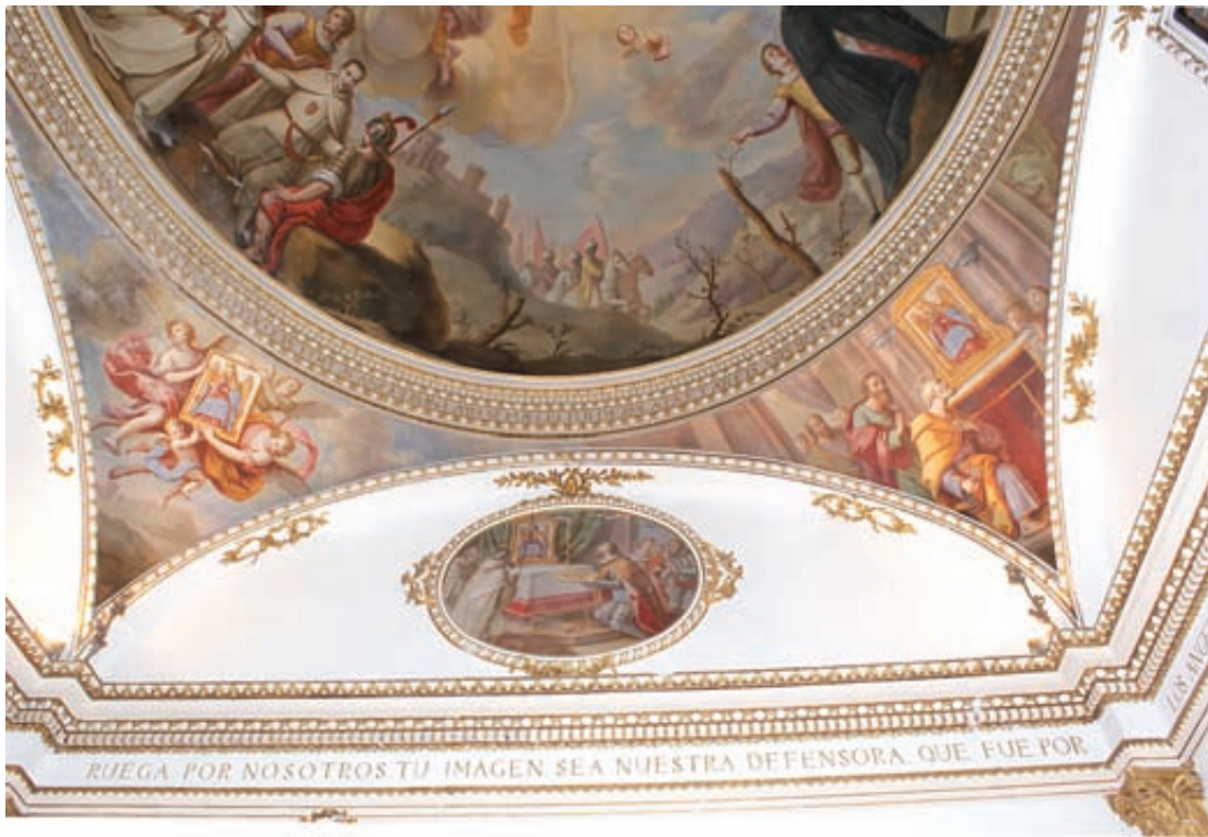
Fig. 2.-Pechinas del muro norte, realizadas por Vergara.
