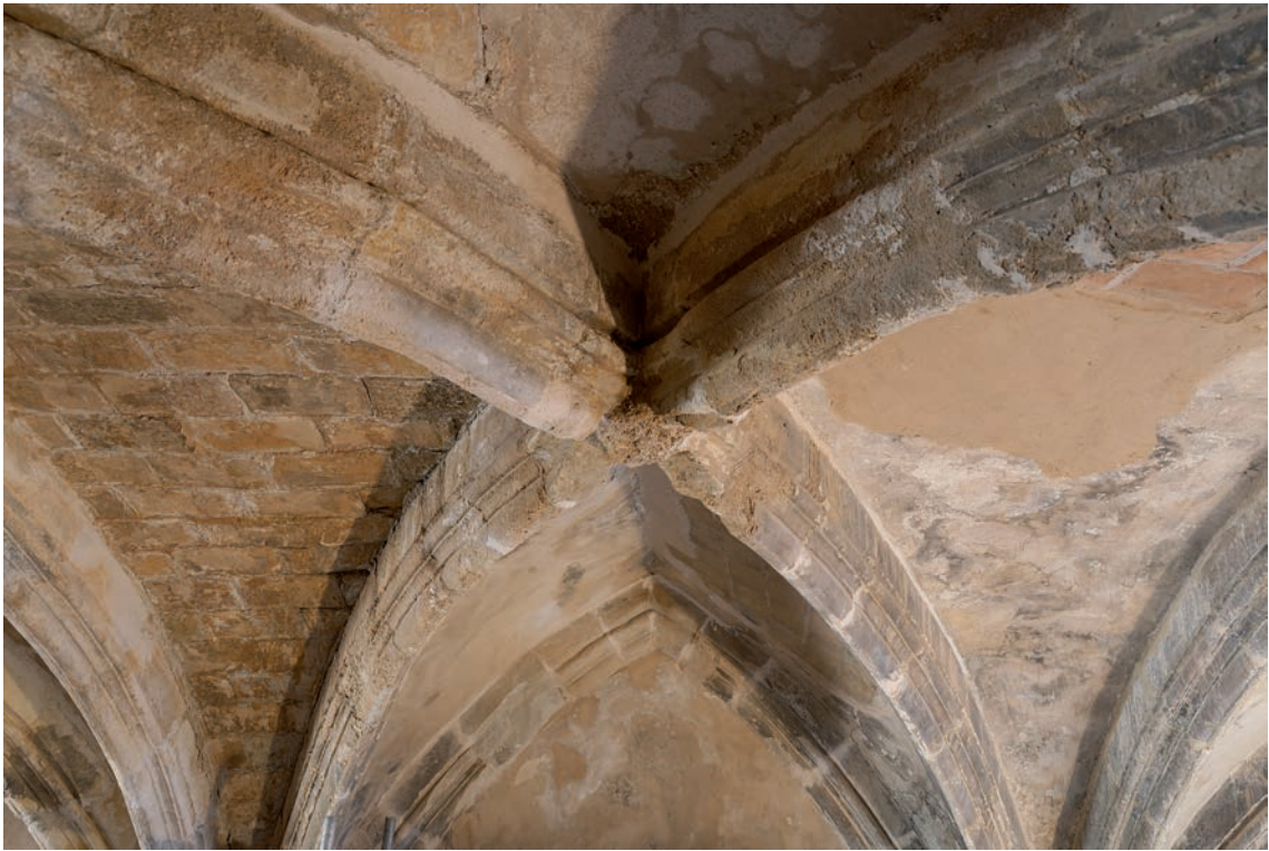
Prefabricados de yeso en bóvedas de crucería. Detalle.
