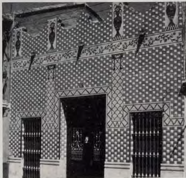
Calle Progreso, 262. Cabañal-Valencia.
