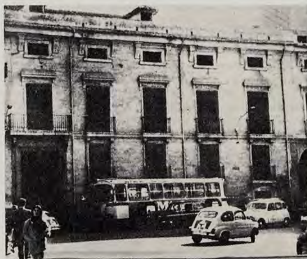
Murcia. Palacio del conde de Floridablanca, por el arquitecto Ramón José Berenguer y Sabater, de la Real Academia de San Carlos, de Valencia.
