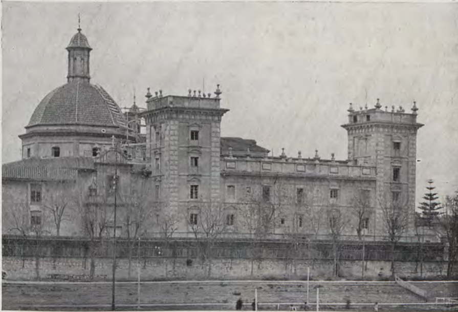
Edificio de San Pío V, hoy Museo de Bellas Artes y Real Academia de San Carlos, antes del derribo de su cúpula
