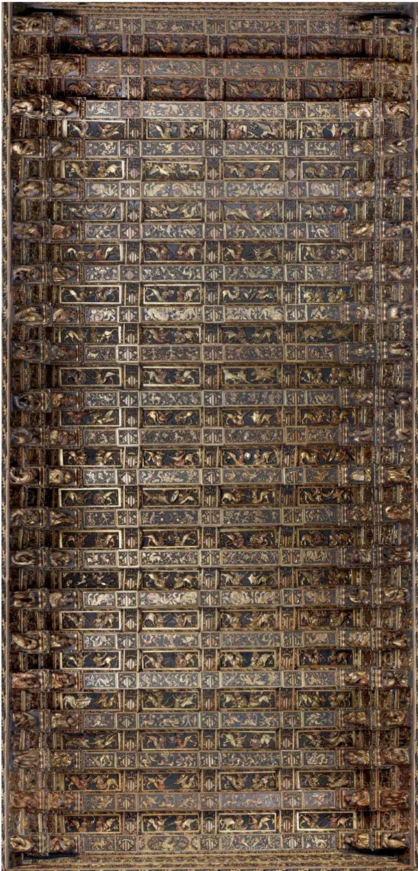
Fig. 1.- Techo de la Sala Dorada de la Casa de la Ciudad.
