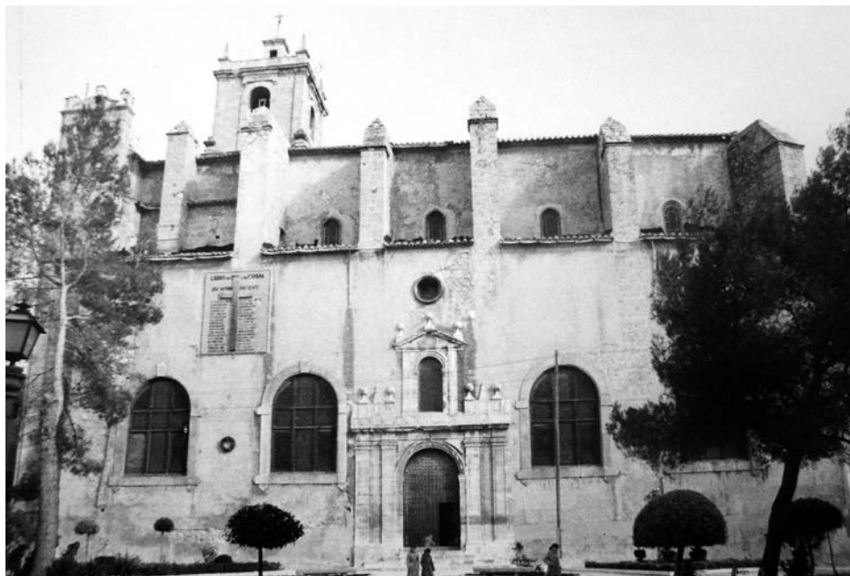
Fig. 7.- Fachada meridional con los ventanales abiertos durante la guerra civil. 1981. Fotografía: J. Alabau.
