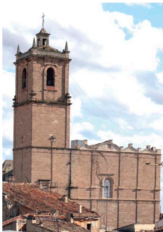
Fig. 4.- Vista de la fachada principal y campanario. Fotografía: P. Febré.
