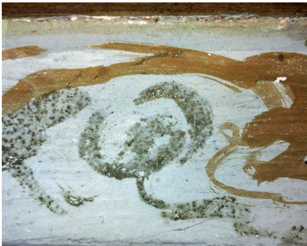
Fig. 7.- Marmoleado de las cornisas del camarín, obra de Isidro Carpena. Se advierten los brochazos de barniz con particulado metálico. Fotografía: Alberto Martínez, 2023.
