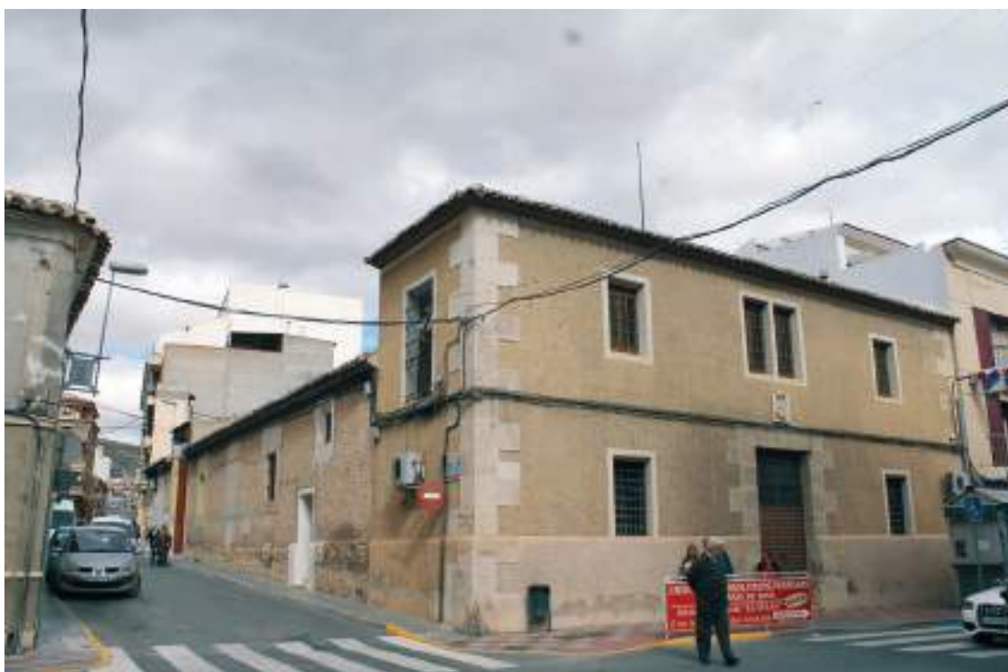
Fig. 3.- Jumilla. El Pósito o antiguo almacén de cereales. (Siglo XVIII, último tercio). Edificio de dos plantas con zócalo y llaves de sillería en la esquina, ha sido consolidado estructuralmente, modificada la cubierta y rehabilitado para museo de una cofradía hace unas décadas (Foto Javier Delicado, 2015).
